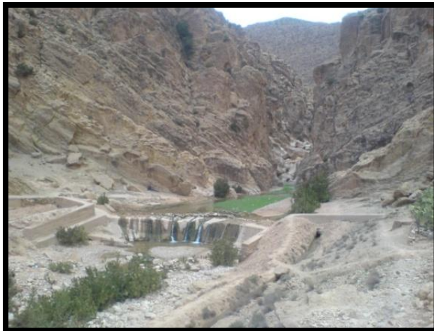
Photo2 distribution des eaux a Tasrift
