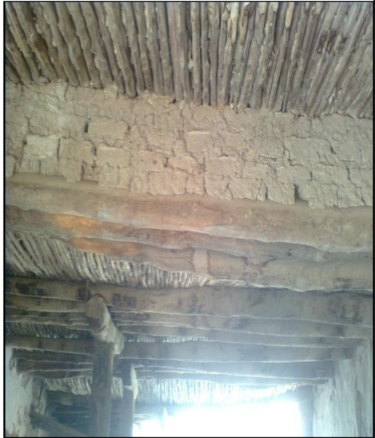
Photo20: structure de la toiture d'une maison à Ménâa
