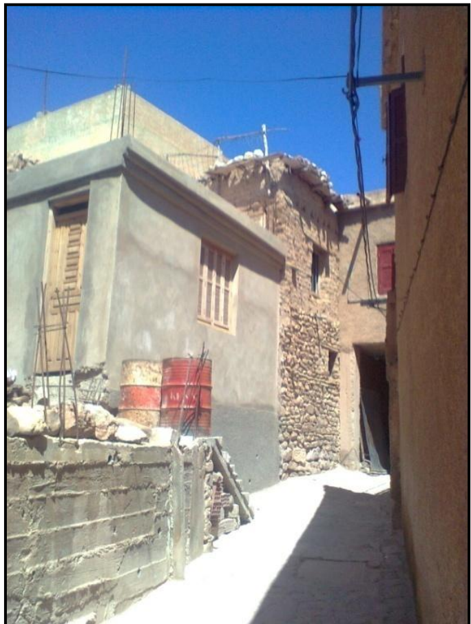
Photo23 : Nouvelle construction dans la déchra
