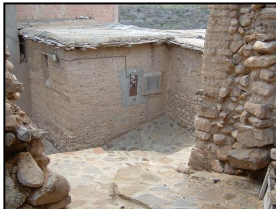
Photo n°25 Dallage à Ménâa
